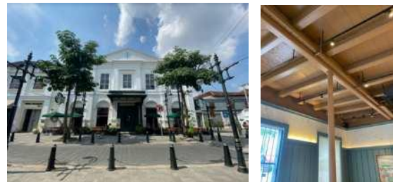
Gambar 7. Perubahan Fungsi Bangunan Yang Diperkuat Serta Penambahan Struktur: Starbucks Coffee (24)
