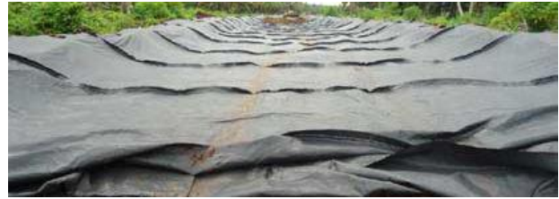
Gambar 4. Material Geotekstil Polyfelt PEC-50 untuk Perkuatan Tanah Lunak
