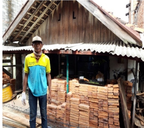
(a) Kondisi sebelum Dilakukan Proses Perbaikan
